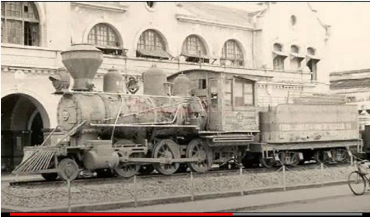
Ex monumento ferroviario situado a la entrada de la estación central de Mérida
