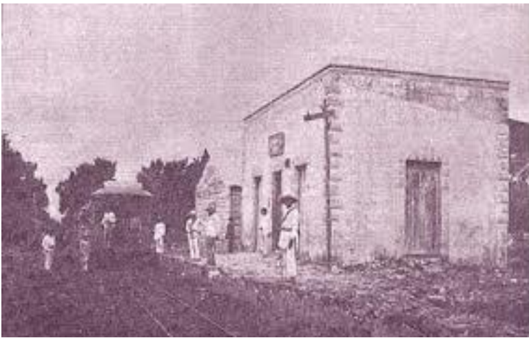
Las estaciones eran muy similares en su arquitectura. Una construcción sencilla rectangular, con techos de lámina unas y de tejas otras, abarcaba un espacio de oficinas con ventanilla para la venta de boletos, escritorio para el jefe de estación
