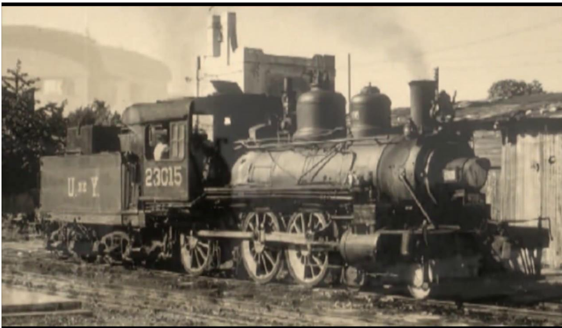
Maquina 23015 de la vía Mérida- Oxkutzcab- Peto, se inauguró el primer tramo el 16 de septiembre de 1881. En la misma fecha, pero casi veinte años más tarde, en 1900, partió a las seis de la mañana el tren inaugural de la estación ubicada frente a los mismos portales de la pescadería, con destino la villa de Peto.
