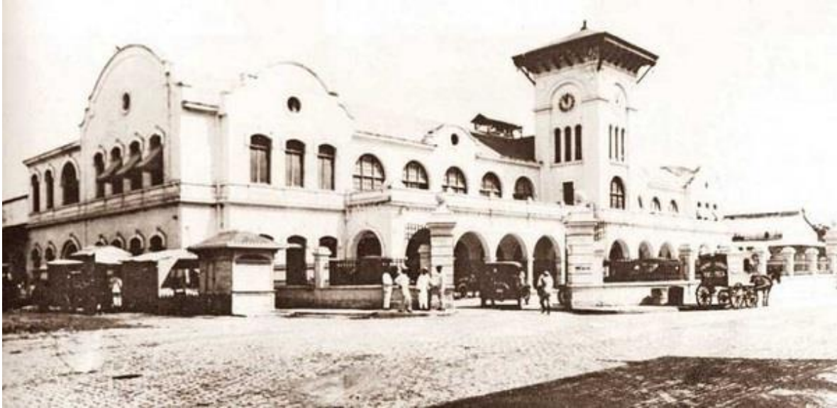
Antigua Estación central de Mérida de los Ferrocarriles Unidos de Yucatán. De estilo Neocolonial Mexicano, se inició su construcción en el año de 1913 y se terminó en 1917 siendo inaugurada el 15 de septiembre de 1920.
